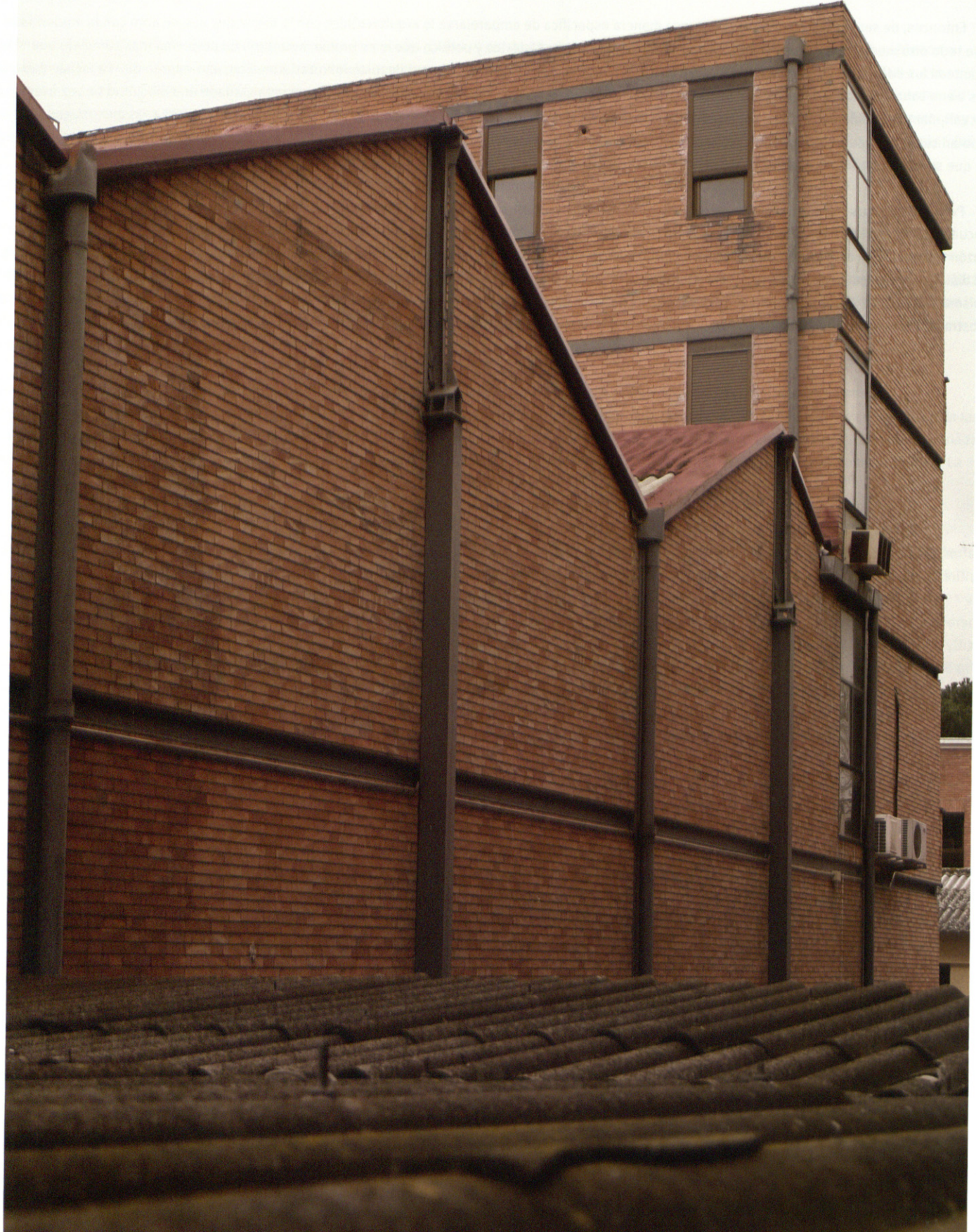
CENIM, Centro Nacional de Investigaciones Metalúrgicas (CSIC), Alejandro de la Sota, 1963, Nave E, Departamento de metalurgia física. Fachada lateral este, Fotografía: Félix Fuentes CENIM, National Center for Metallurgical Research (CSIC), Alejandro de la Sota, 1963, Building E, Physical Metallurgy Department. East side façade. Photography: Félix Fuentes
